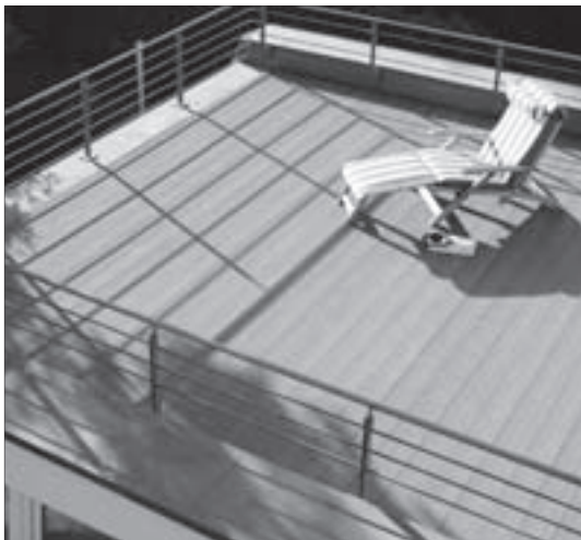
Терраса на крыше
