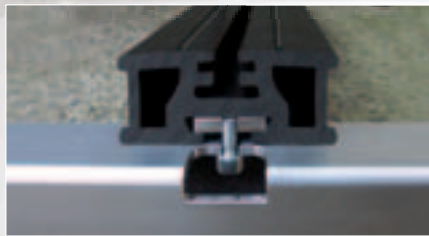
Монтаж на стальной конструкции
